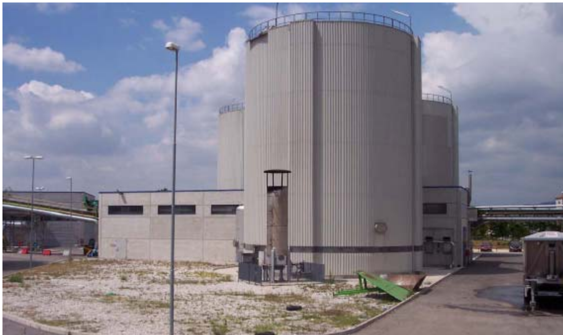
Slika 5. Anaerobni digestor u kojem se proizvodi bioplin
